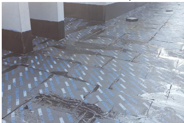
3. Pose de la plaque joints serrés et décalés. Les côtés trempés de bitume sont posés en contact avec les plaques déjà en place.
