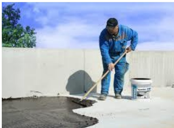
1. Application de L'enduit d'imprégnation à froid
