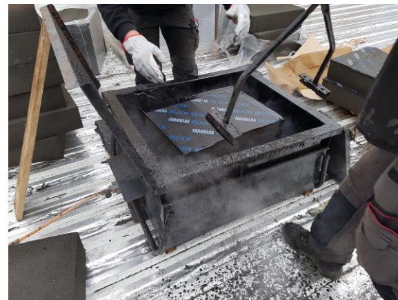
2. Tremper la sous face de la plaque
