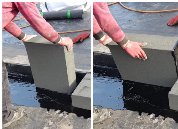
2. Tremper le petit et grand côté de la plaque (Consommation: min 5 kg/m 2 )*
