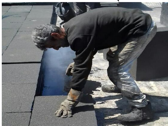
3. Pose de la plaque joints serrés et décalés. Les côtés trempés de bitume sont posés en contact avec les plaques déjà en place.
