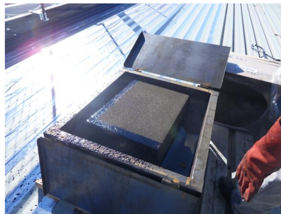
2. Tremper la sous face de la plaque
