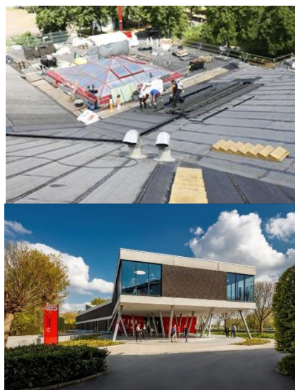
Fig 3 : Installation du produit FOAMGLAS® T3+
