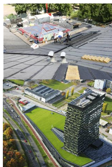
Fig 3 : Installation du produit FOAMGLAS® S3
