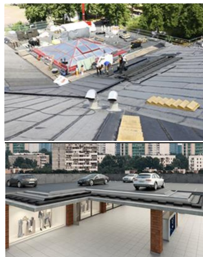
Fig 3 : Installation du produit FOAMGLAS® F
