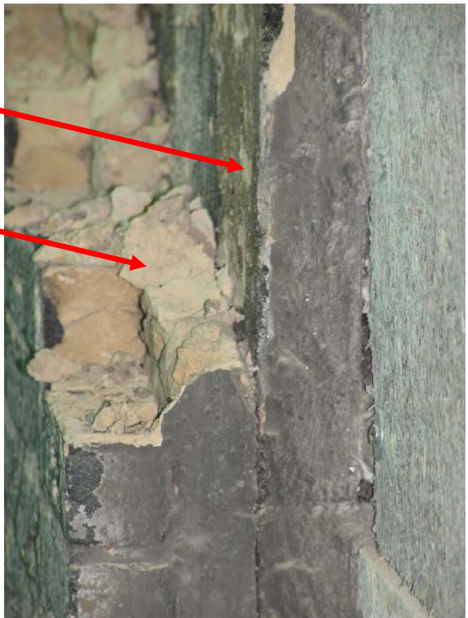
Fassade mit bereits zum Teil entfernter Vorsatzschale
