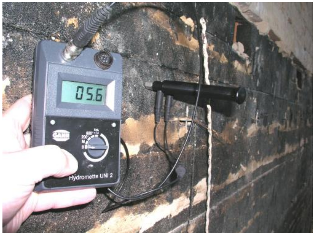
Messung am eingebauten Dämmstoff
