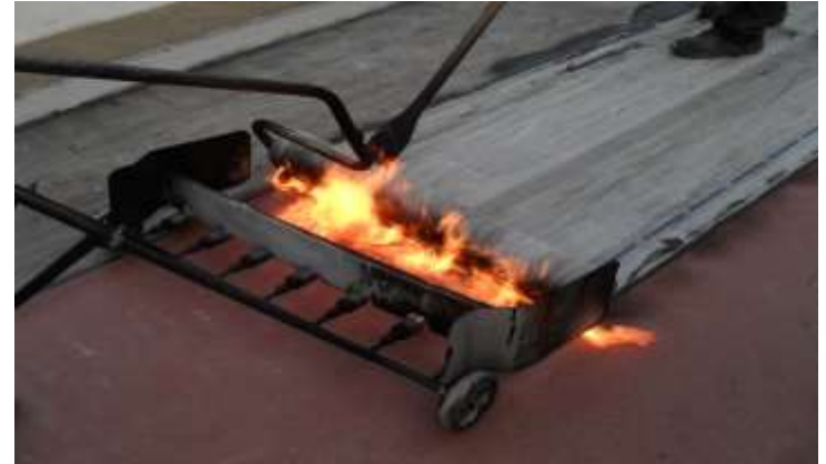
Abdichtungsschicht aus Polymerbitumen-Schweißbahn
