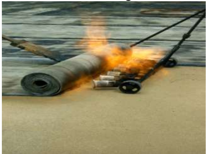
Abdichtungsschicht aus Polymerbitumen-Schweißbahn
