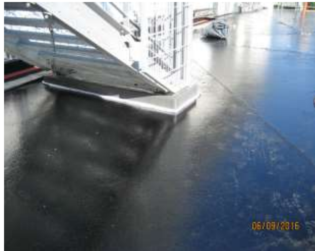
Bauweise 1a mit Manschette
