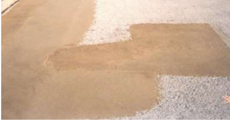
Untergrund vorbehandelt; EP- Grundierung, Versiegelung, Kratzspachtelung
