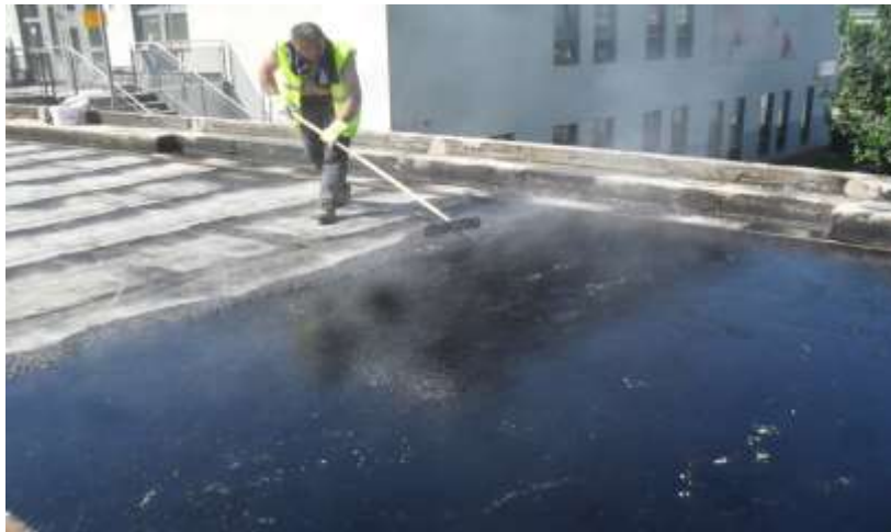
Abdichtungsschicht aus Gussasphalt
