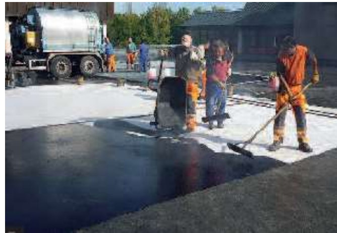
Abdichtungsschicht aus Gussasphalt
