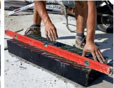
Justierung mit der Wasserwaage.
