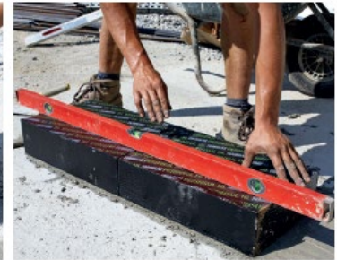
Justierung mit der Wasserwaage.
