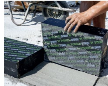
Dämmstein stumpf gestoßen in Mörtelbett.
