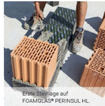
Dämmstein stumpf gestoßen in Mörtelbett.
