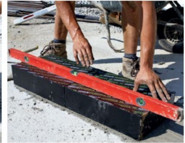
Justierung mit der Wasserwaage.
