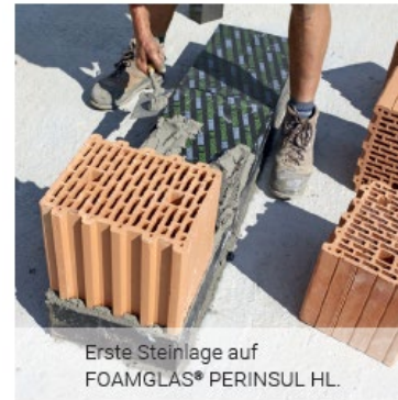
Dämmstein stumpf gestoßen in Mörtelbett.
