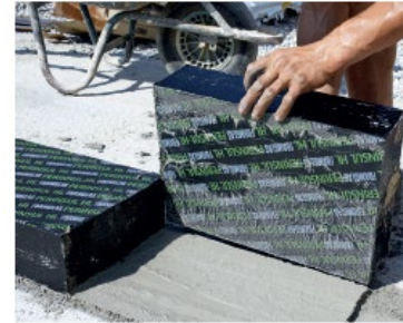
Dämmstein stumpf gestoßen in Mörtelbett.
