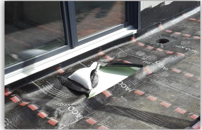
Die Verformung der Dämmschicht führt zu einer Ablösung der Abdichtung. Die mechanische Beanspruchung der Abdichtung ist so deutlich höher. Schäden sind mit grösserer Wahrscheinlichkeit zu erwarten.
