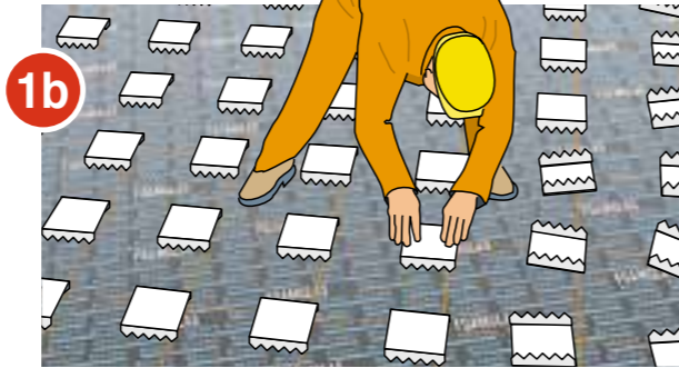
1b Utlegging av taggbrikker på FOAMGLAS® Ready Board.
