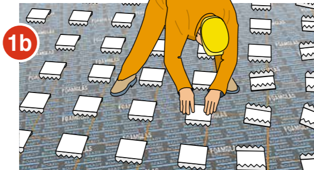
1b Utläggning av taggbrickor på FOAMGLAS® Ready Board.
