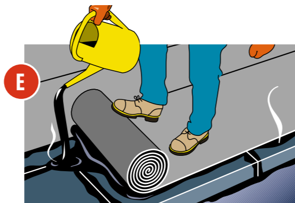
Exempel på utläggning av helklistrat tätskikt.
