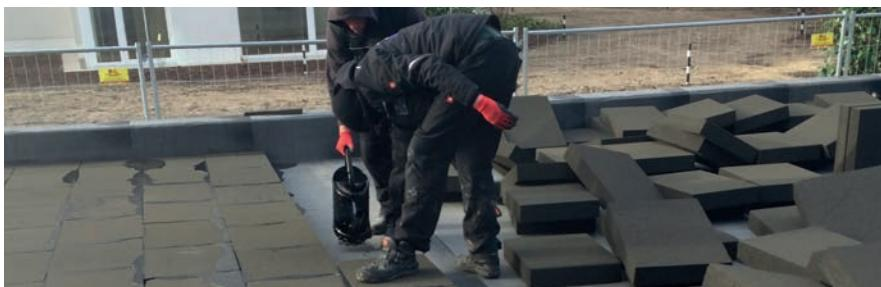
Die Dämmplatten wurden mit einer Heißbitumenklebemasse vollflächig und vollfugig eingeschwemmt.
