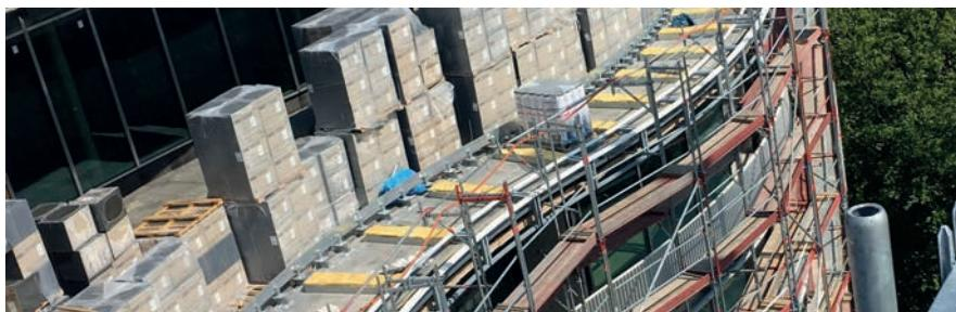
Bei der Ausführung der Dachterrassen im sechsten und siebten Obergeschoss kam FOAMGLAS® T4+ zum Einsatz.
