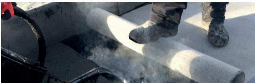
Nach dem Verkleben wurde eine zweilagige, bituminöse Abdichtung – direkt auf der Dämmung – hergestellt.
