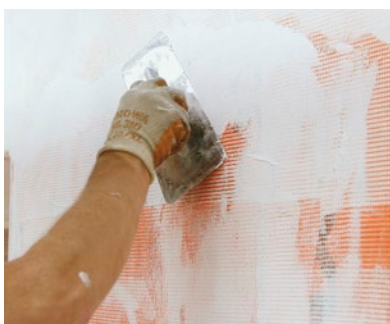
Lastre FOAMGLAS®, incollate con colla a freddo PC® 56 e intonacate PC® 164, PC® 78 / PC® 74 A1, PC® FINISH 0, 1 e 2.5
