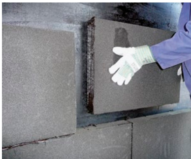
Plaques FOAMGLAS®, collées avec la colle PC® 56
