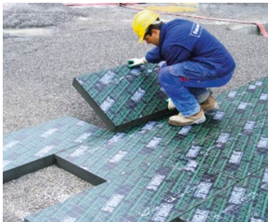
Panneaux FOAMGLAS® Boards, posés à sec
