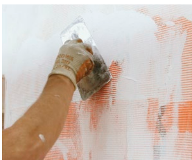
Plaques FOAMGLAS®, collées avec la colle PC® 56 et crépi PC® 164, PC® 78 / PC® 74 A1, PC® FINISH 0, 1 et 2.5
