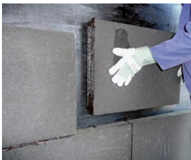
FOAMGLAS® Platten geklebt mit Kaltkleber PC® 56
