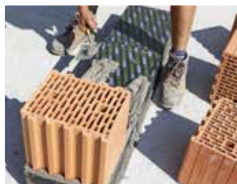
Erste Steinlage auf FOAMGLAS® PERINSUL HL.
