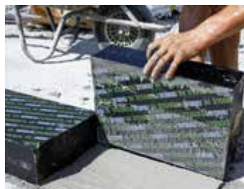
Dämmstein stumpf gestoßen in Mörtelbett.
