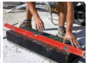
Justierung mit der Wasserwaage.
