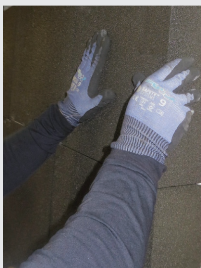
Plaatsen van FOAMGLAS®
