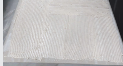
Lijm op grootformaattegel
