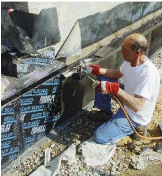
Branden van de afdichting op de FOAMGLAS® READY BOARD
