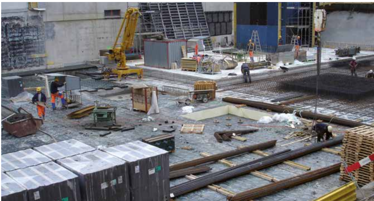
Lavori in cantiere Posa di pannelli FOAMGLAS® Board su magrone
