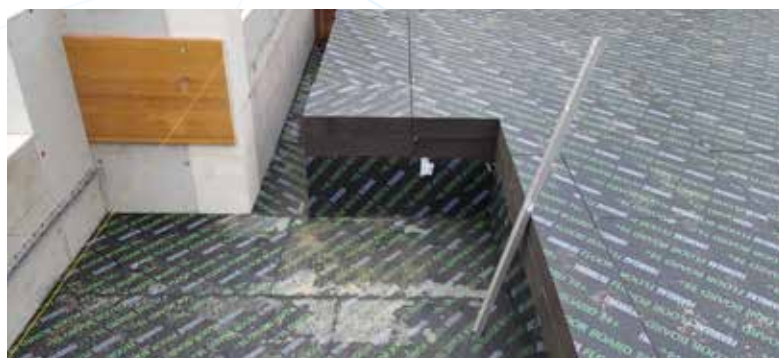
Lavori in cantiere Rappresentazione in dettaglio di un'incavatura delle fondamenta con pannelli FOAMGLAS® Board
