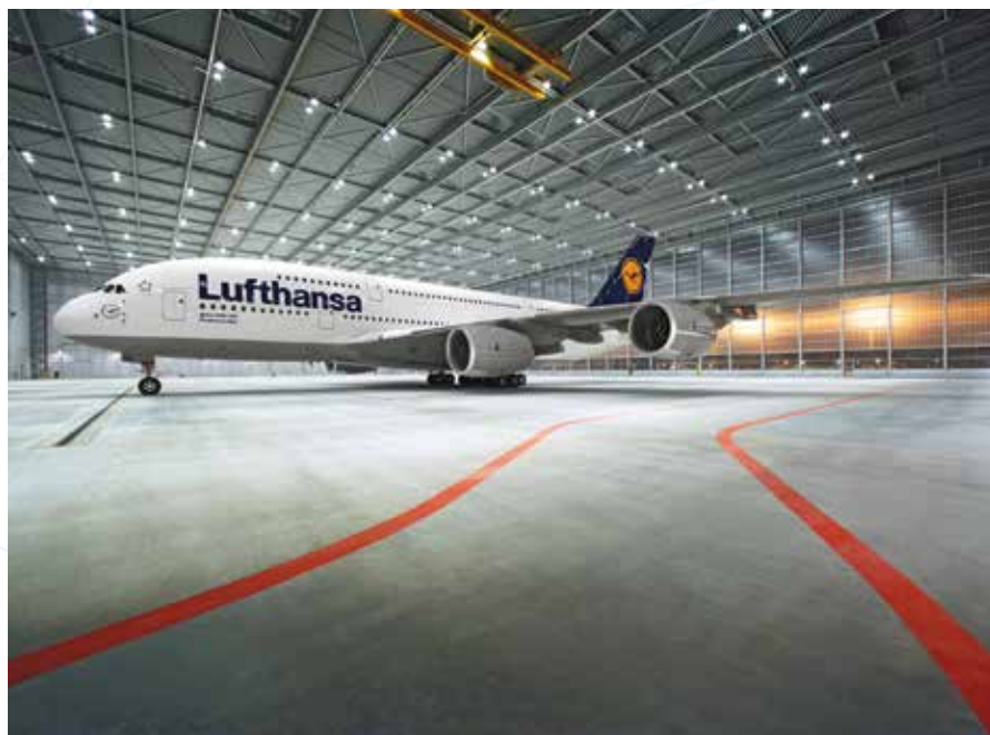
Lufthansa, nuovo hangar per la manutenzione dell'airbus A380, Francoforte, Germania Architetto gmp - Architekten von Gerkan, Marg und Partner Inaugurazione 2007 Applicazione FOAMGLAS® Sotto pavimento sottoposto a carico
