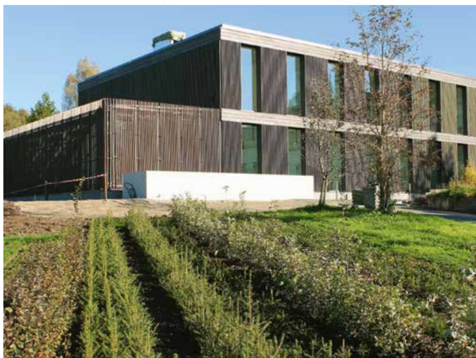
Laboratorio di difesa fitosanitaria dell'Istituto fed. di ricerca per la foresta, la neve e il paesaggio WSL, Birmensdorf (ZH) Architetto Burckhardt + Partner AG, Basilea Anno di realizzazione 2014 Applicazioni FOAMGLAS® Isolamento contro terra bistrato ca. 1 000 m 2 , FOAMGLAS® Floor Board T4+, spessore 100 mm, FOAMGLAS® T4+, spessore 100 mm. Isolamento della parete ca. 550 m 2 , FOAMGLAS® T4+, spessore 200 mm
