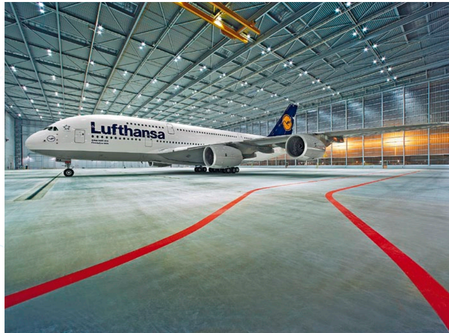
Lufthansa, New A380 Maintenance Hangar, Frankfurt, Deutschland Architekt gmp – Architekten von Gerkan, Marg und Partner Eröffnung 2007 Anwendung FOAMGLAS Unter belasteten Boden
