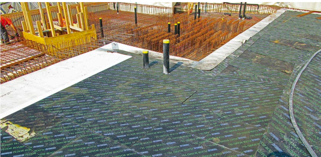
Baustellensituation Fertig verlegte Fläche mit FOAMGLAS Floor Board
