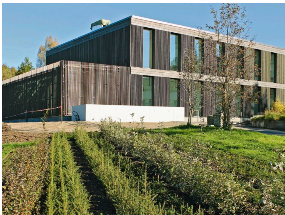
Pflanzenschutzlabor der Eidg. Forschungsanstalt WSL, Birmensdorf (ZH) Architekt Burckhardt + Partner AG, Basel Ausführungsjahr 2014 Anwendung FOAMGLAS Bodendämmung zweilagig ca. 1 000 m 2 , FOAMGLAS Floor Board T4+, Dicke 100 mm, FOAMGLAS T4+, Dicke 100 mm. Wanddämmung ca. 550 m 2 , FOAMGLAS T4+, Dicke 200 mm
