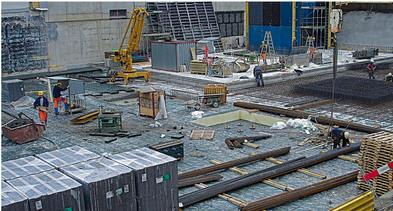
Baustellensituation Verlegung von FOAMGLAS Boards auf Sauberkeitsschicht
