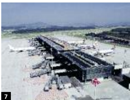
7 Zurich Airport, Kloten
