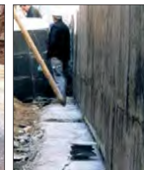
Bombeo de hormigón impermeabilizado. El aislamiento se realiza con placas FOAMGLAS® S3 de 8 cm.
