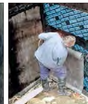
Soldadura de la capa de Estanqueidad sobre un aislamiento FOAMGLAS® READY BOARD.
