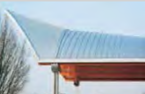
Acabado en junta alzada de acero inoxidable, zinc y cobre
