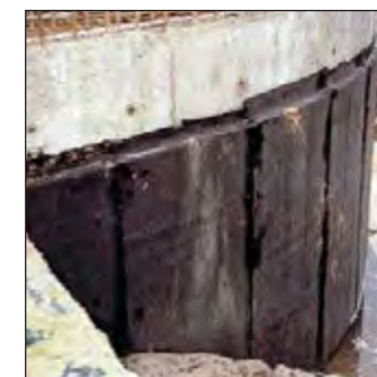
El aislamiento FOAMGLAS® READY BOARD se aplica sobre un muro circular de basamento.
