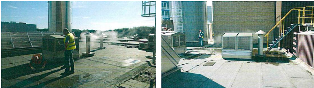
Abbildung 1: Blick auf das begutachtete Gebäude / die Flachdachkonstruktion
