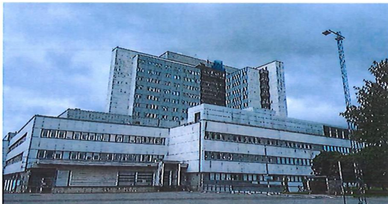
Abbildung 1: Blick auf das begutachtete Gebäude / die Flachdachkonstruktion
