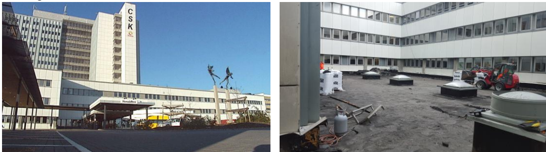
Abbildung 1: Blick auf das begutachtete Gebäude / die Flachdachkonstruktion
