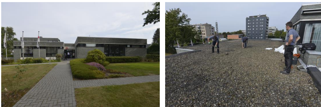
Abbildung 1: Blick auf das begutachtete Gebäude / die Flachdachkonstruktion
