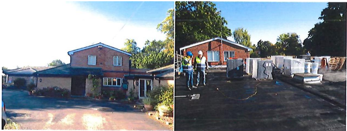
Abbildung 1: Blick auf das Gebäude / die begutachtete Flachdachkonstruktion
