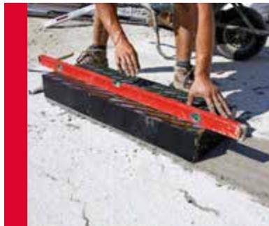
Justierung mit der Wasserwaage.
