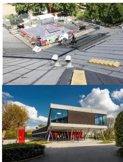
Fig 3 : Installation du produit FOAMGLAS® T3+
