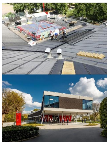
Fig 3 : Installation du produit FOAMGLAS® T3+
