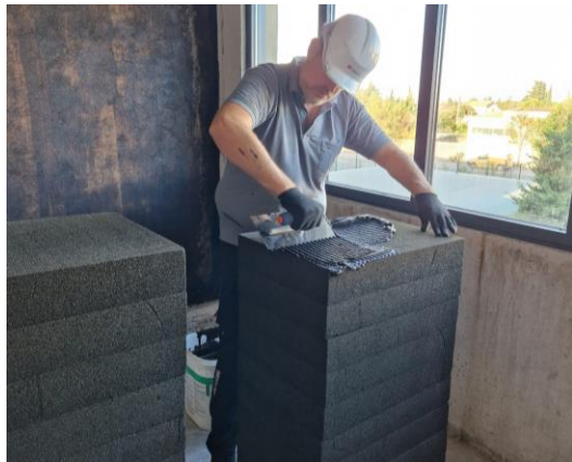
3. Etaler la colle à froid en plein sur une face avec la taloche dentée.
