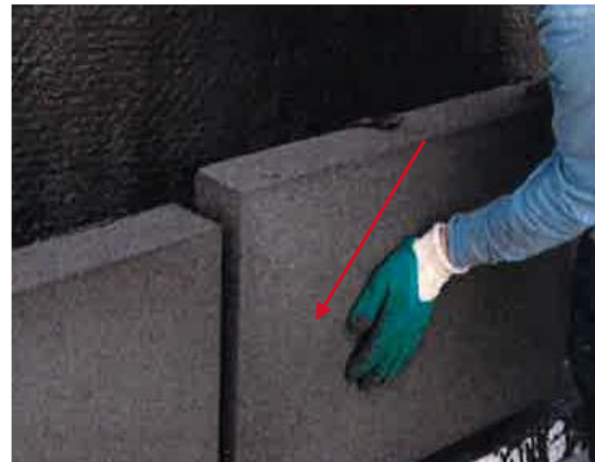
4. Glisser diagonalement le FOAMGLAS® dans l'angle ouvert.
