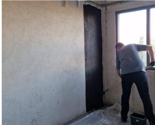
1. Préparation du primaire et application de l'E.I.F (une dose de PC 56 pour dix d'eau et mélanger)
