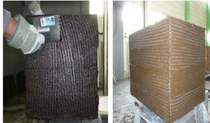
2. Appliquer la colle à froid PC® 56 au moyen d'une taloche dentée (dents ~ 8 – 10 mm) sur deux chants adjacents du FOAMGLAS®
