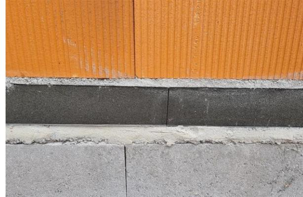
6. La mise en œuvre de la maçonnerie se fera sur un lit de mortier et conformément aux prescriptions du fournisseur
