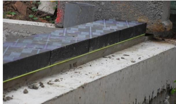
4. Les joints verticaux seront serrés et sans mortier
