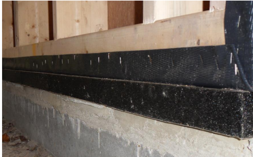
5. Positionner l'ossature bois et la fixer au support
