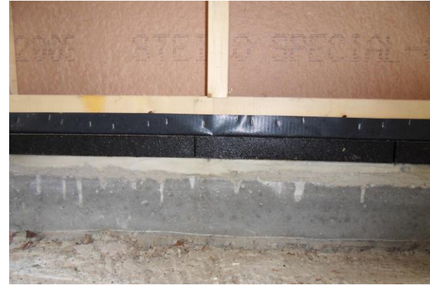
6. Mise en œuvre d'une bande anti remontée d'humidité
