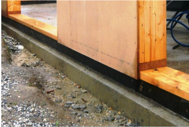
5. Positionner l'ossature bois et la fixer au support
