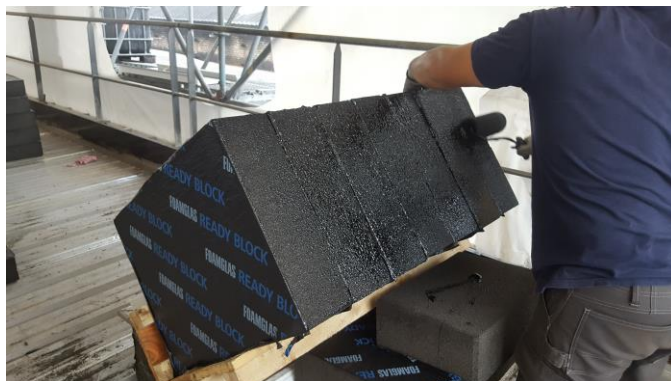
Chevalet à réaliser sur chantier : gain de temps et facilité de l'encollage
