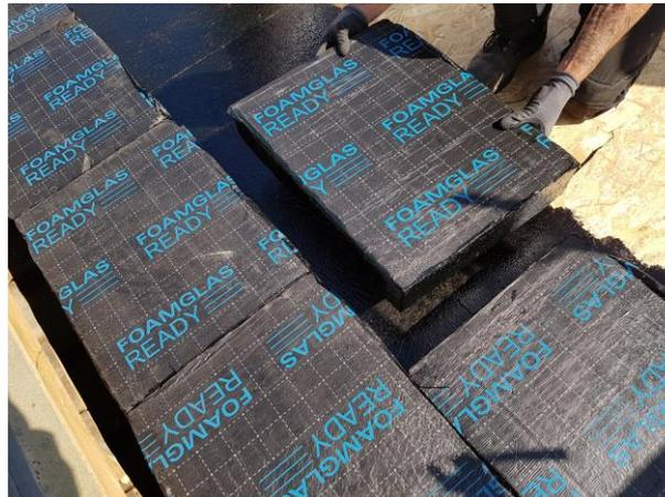
Encollage du support bois à l'aide du rouleau crépis fin munis d'un manche long et poser la plaque de façon à ce que les chants encollés viennent en contact avec les plaques déjà posées. Attention procéder par tranches d'environ 5M2
