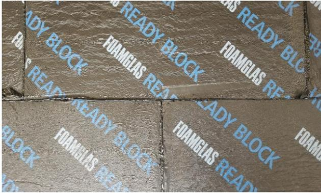
Pose à joints serrés et remplis
