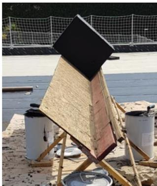
Chevalet à réaliser sur chantier : gain de temps et facilité de l'encollage
