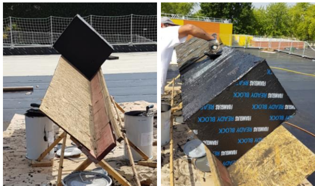
Chevalet à réaliser sur chantier
