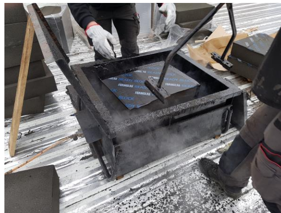
2. Tremper la sous face de la plaque
