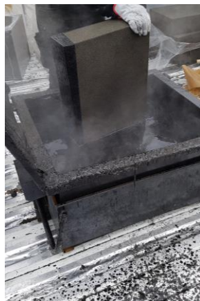
1. Tremper le petit et grand côté de la plaque (consommation: 1,2 kg/m 2 )*
