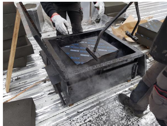
2. Tremper la sous face de la plaque
