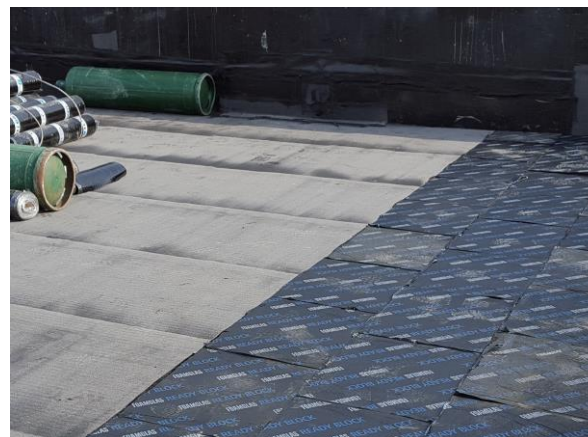
4. Pose de la plaque joints serrés et décalés. Les côtés trempés de bitume sont posés en contact avec les plaques déjà en place.
