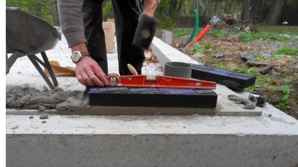
2. Tapoter avec le maillet caoutchouc ou le PLAT de la truelle sur le bloc pour le mettre de niveau
