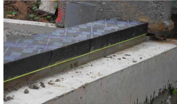
4. Les joints verticaux seront serrés et sans mortier
