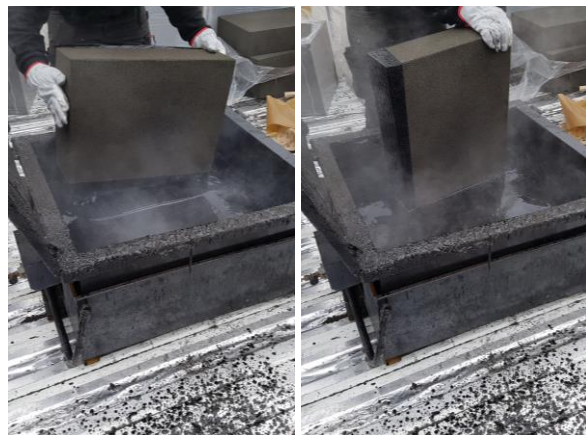
1. Tremper le petit et grand côté de la plaque (consommation: 1,2 kg/m 2 )*
