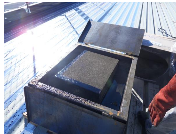
2. Tremper la sous face de la plaque
