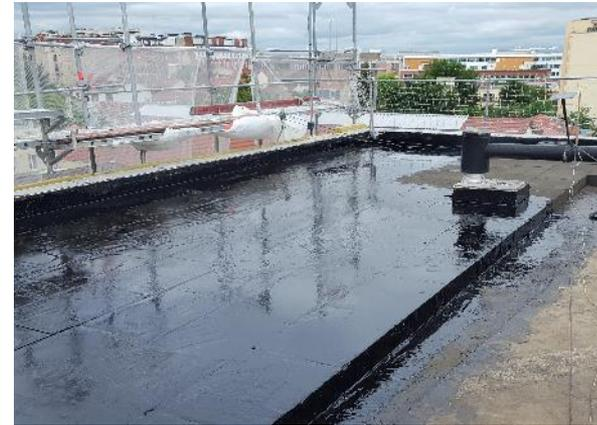
5. Les cellules de surface du Foamglas® ne doivent plus être visibles.
