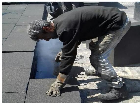
3. Pose de la plaque joints serrés et décalés.
