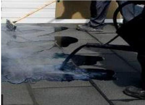
4. Verser du bitume chaud sur la surface des plaques nues et le répartir au moyen d'un racloir en caoutchouc
