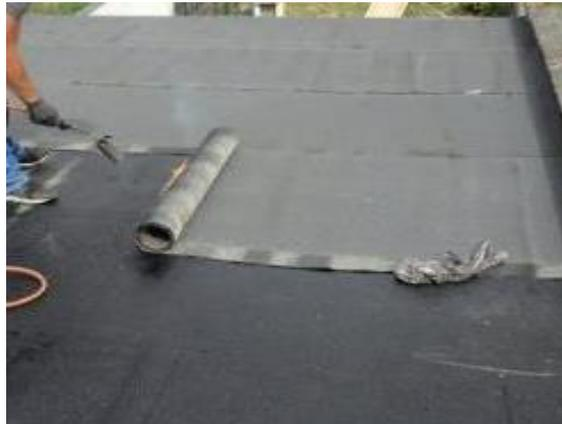
6. 1ère couche d'étanchéité soudée à la flamme en pleine adhérence sur le glacis de bitume.
