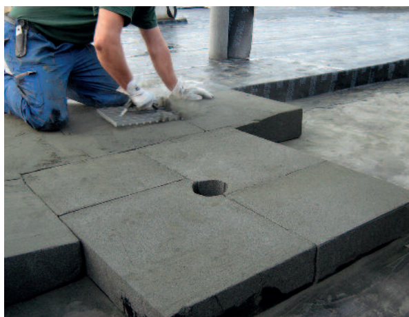
Traitement des eaux pluviales par plaques FOAMGLAS®
