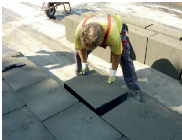
Disposition des plaques FOAMGLAS® TAPERED numérotées
