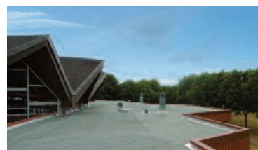
Rénovation du Mess B.A 721, Rochefort (17) Entreprise : MAE (31) Terrasse inaccessible avec pente 3,3%
