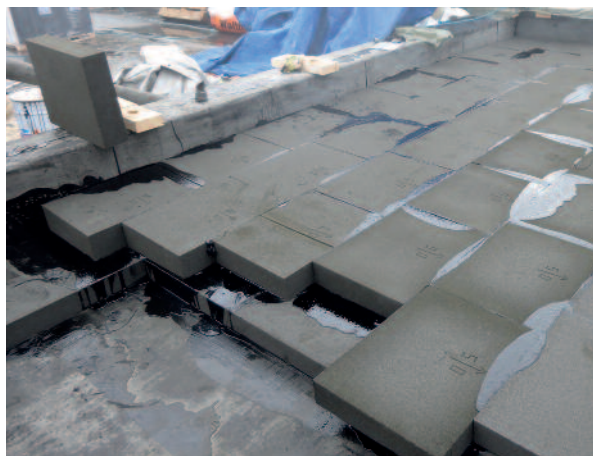
Collage des plaques FOAMGLAS® TAPERED à chaud
