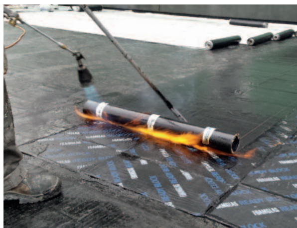
Pose membrane d'étanchéité sur panneaux FOAMGLAS® TAPERED
