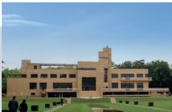
Villa Cavrois, Croix - Entreprise : Sorec (59) Terrasse accessible piétons avec pente 1,1%
