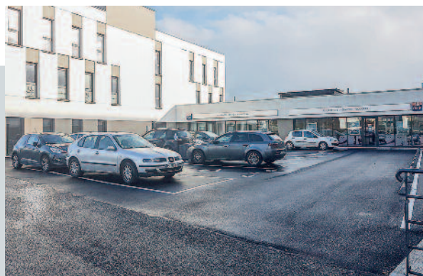
Parking Longchamps, Rennes - Mercier Ass. (35), Entreprise : SEO (35) Terrasse accessible véhicules avec pente 1,1%
