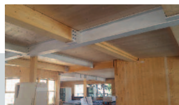
Sous-face de panneaux horizontaux.
