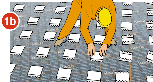
1b Udlægning af tagbrikker på FOAMGLAS® Ready Board.
