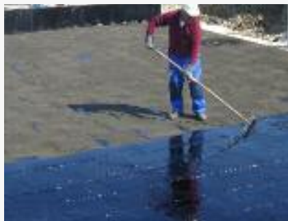
FOAMGLAS® Platten in Heißbitumen (Gießverfahren)
