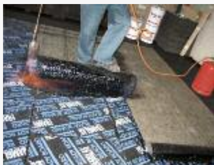
FOAMGLAS® READY BOARD, geklebt mit PC® 56, Schweißbahn
