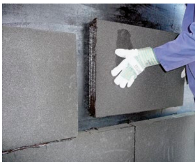
Plaques FOAMGLAS®, collées avec la colle PC® 56
