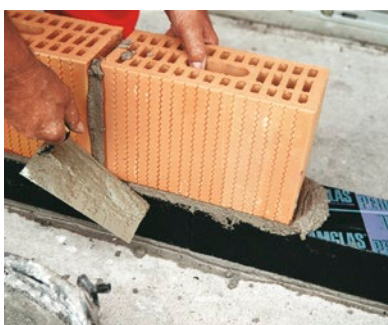
FOAMGLAS® PERINSUL, élément d'isolation porteur sous maçonnerie
