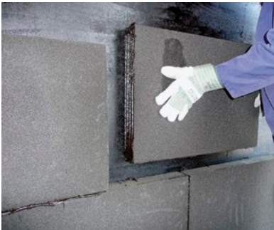
FOAMGLAS® Platten geklebt mit Kaltkleber PC® 56
