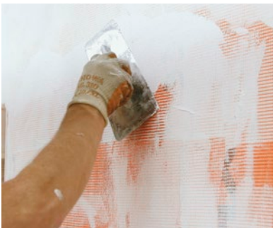
FOAMGLAS® Platten geklebt Kaltkleber PC® 56, verputzt mit PC® 164, PC® 78 / PC® 74 A1, PC® FINISH 0, 1 und 2.5
