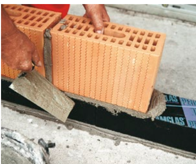
FOAMGLAS® PERINSUL Tragendes Wärmedämmelement unter Mauerwerk
